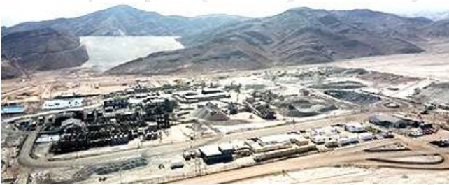
Planta Concentradora las Luces
